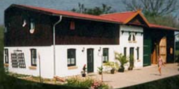
Scheune mit 3 Ferienwohnungen
